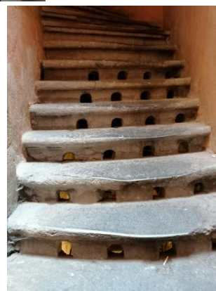
Escalier troué aérer la cave
