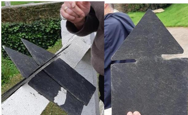
Pour la jonction des pans de toiture, on taille et on emboîte les ardoises pour réaliser un faîtage étanche dit en « lignolet croisé »
