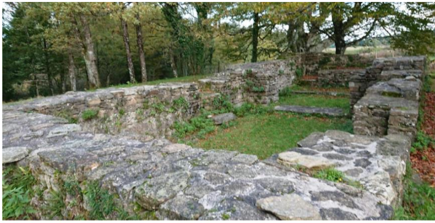
Chapelle après reconstruction des murs de base.
