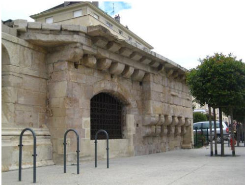
Mur de Bourg-le-Roi au pied de l'église Saint-Pierre
